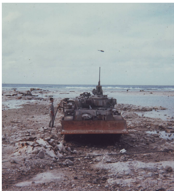
TRAVAUX à Denise (1,3 Km du point zéro à J +1)
